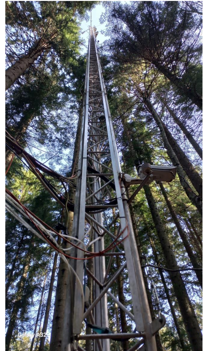
FOTO 4 particolare traliccio esistente
